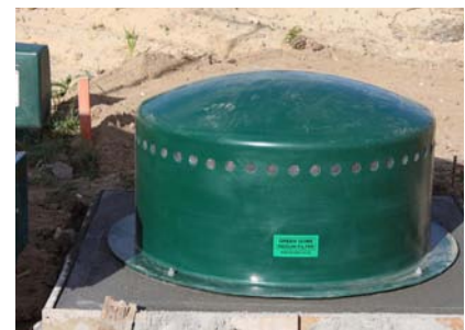
Pour concrete pad with hold-down bolts.
